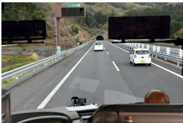
◎高速走行トンネル走行（北関東自動車道）
